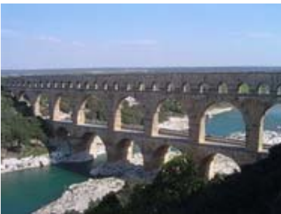
Le pont du
